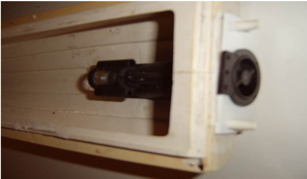
Antrieb eingepasst
